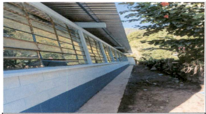
Foto 4: Pintura en muros exteriores e interiores
