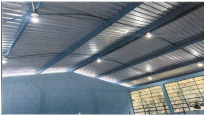
Foto 3: Mantenimiento a estructura de soporte de metal
