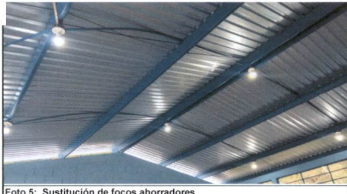
Foto 5: Sustitución de focos ahorradores
